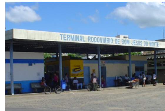
Terminal Rodoviário de Bom Jesus do Norte
